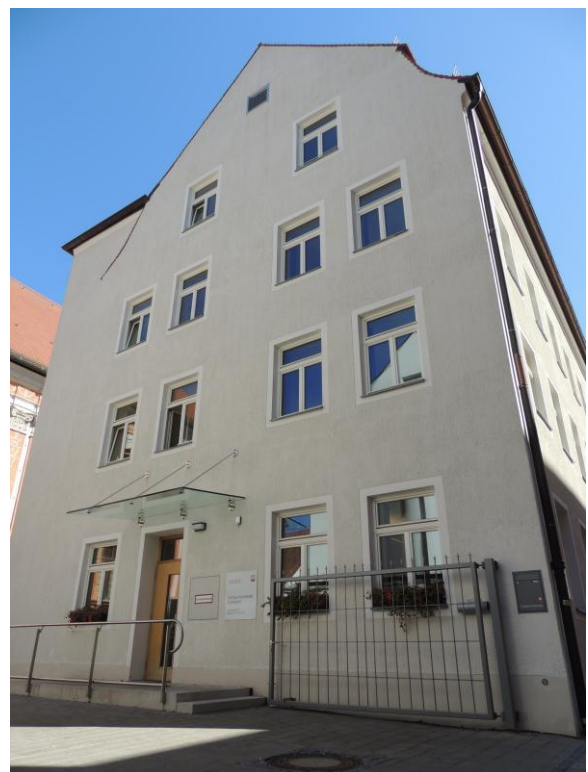
Eingangsbereich (Westseite) in der Jesuitenstraße
