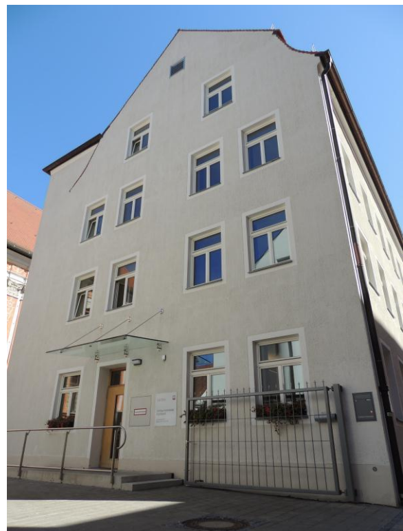
Eingangsbereich (Westseite) in der Jesuitenstraße
